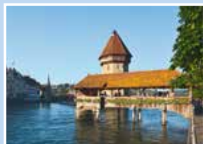
Kappelbrücke, Kanton Luzern
